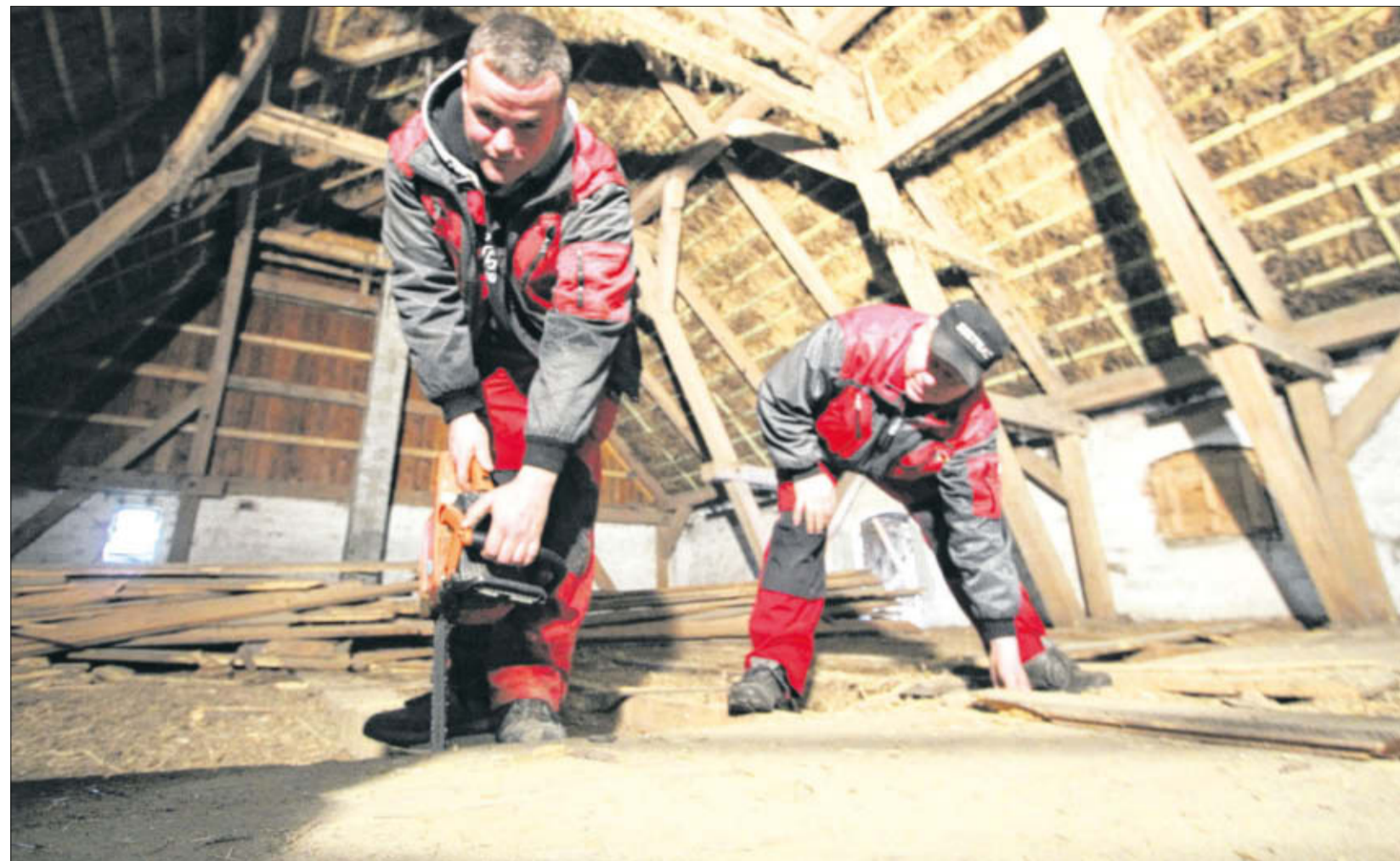
Jan Bremer (li.) und Günter Falk legen im Obergeschoss des Pferdestalls der alten Oberförsterei die tragenden Balken frei.
