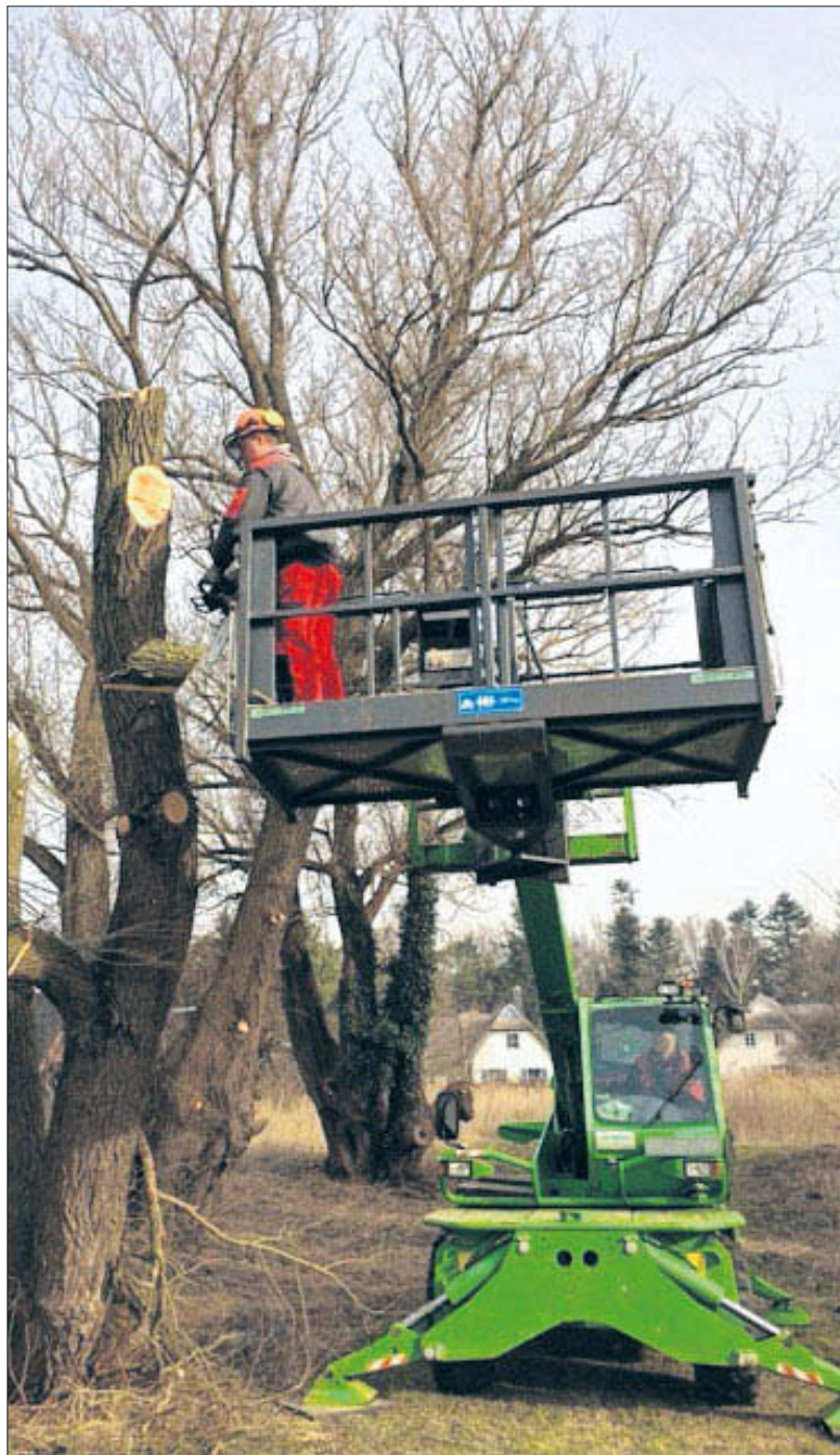
Seit Tagen erfolgen in Born Baumarbeiten: Im Fischergang wurden Weiden von Mitarbeitern des Bauhofes zurückgeschnitten. Foto: privat
