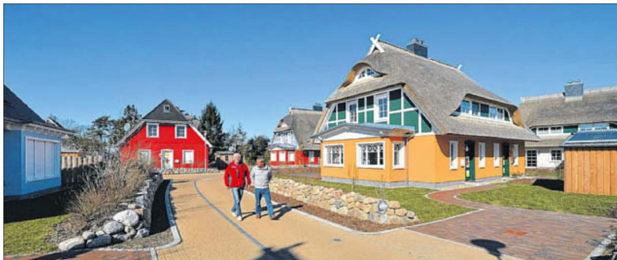
Eine neue Ferienhaussiedlung am Rand des Dorfs: So oder ähnlich könnte eine zukünftige Bebauung des Borner Holms aussehen. Genaue Pläne gibt es aber noch nicht.
