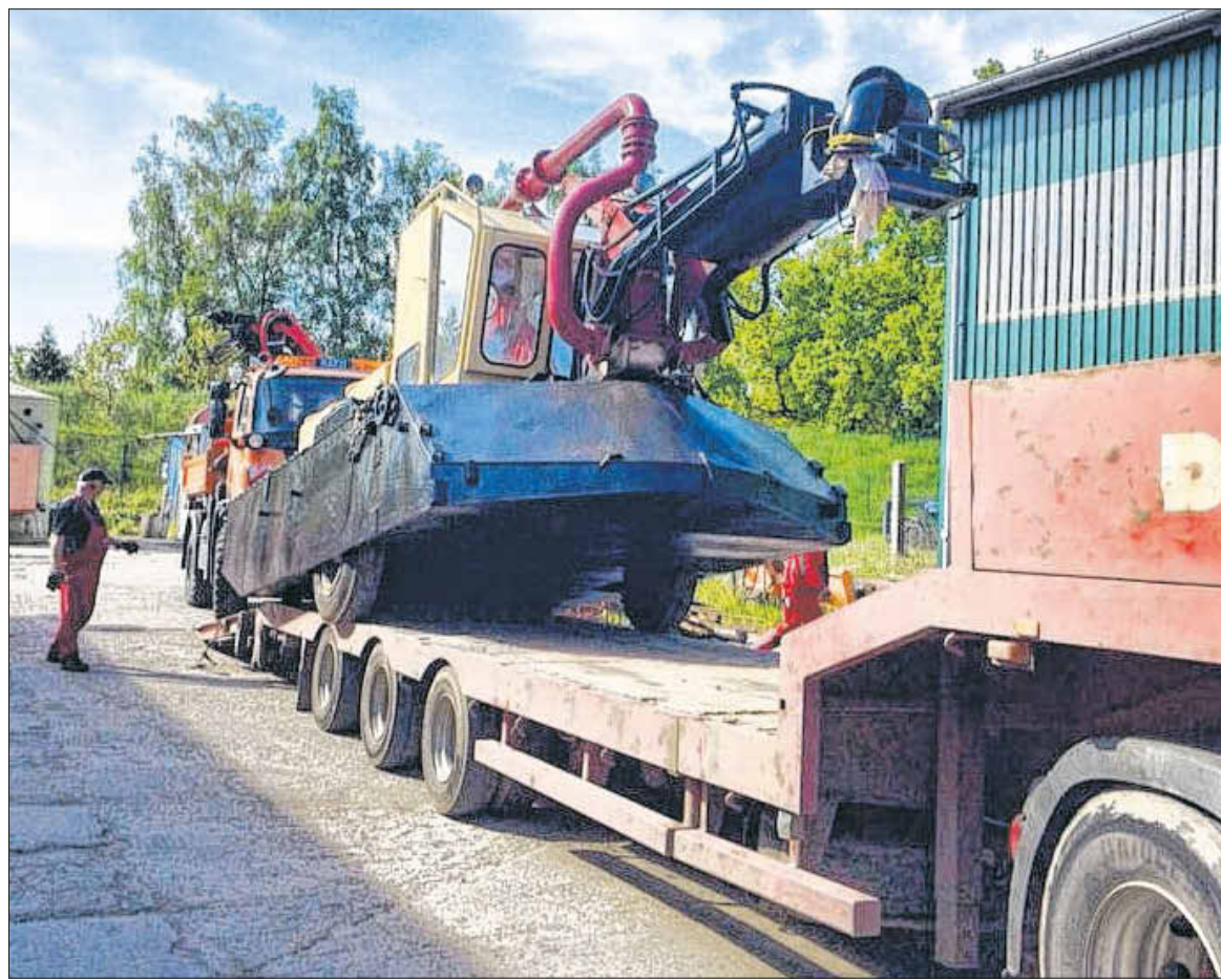
Auf dem Gelände des Born Bauhofes wurde gestern der Saugbagger verladen.
